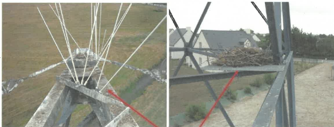
Figures 22 & 23 : Pose de pics PFISTERER et caillebotis pour l'accueil de nid (RTE)
